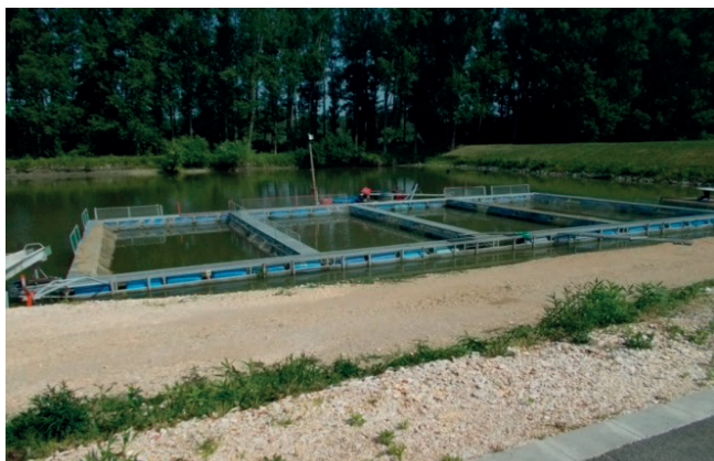
Védőkorlátok hiánya a haltárolónál és a hozzá vezető bejárónál
